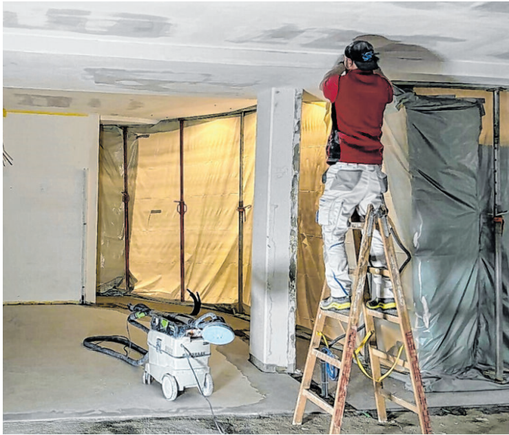
Die Umbauarbeiten wurden bei laufendem Betrieb reibungslos abgewickelt.
